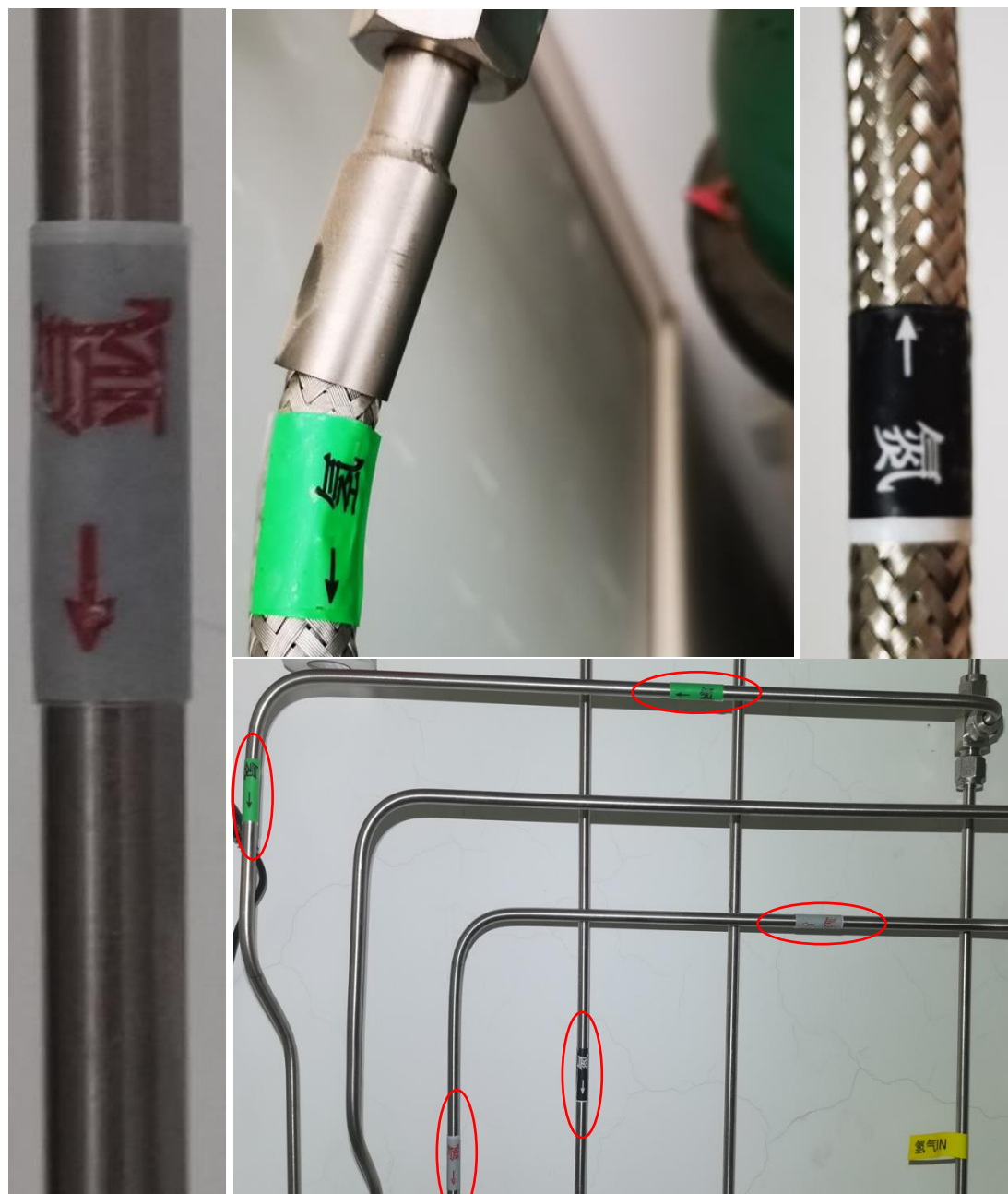
图二：粘贴气路方向标识（细管效果不好、待更换）
