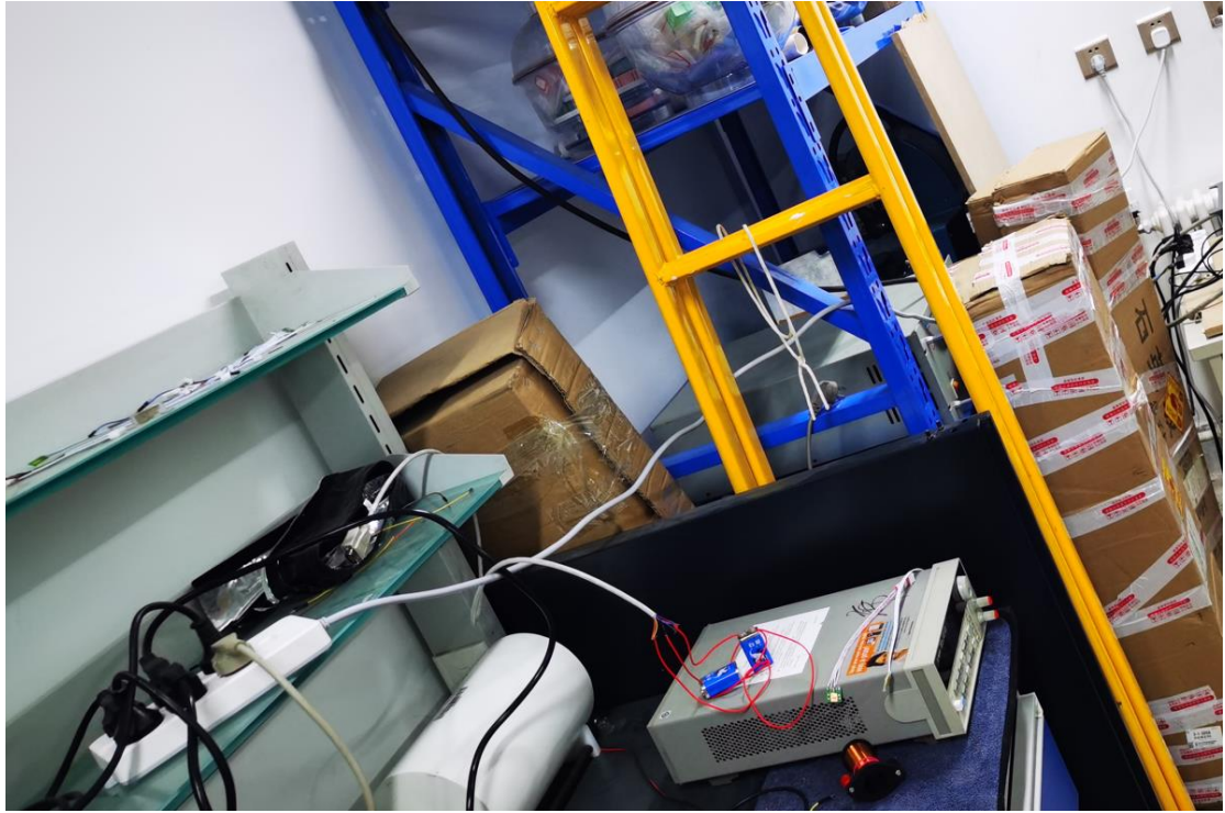
图六：插座串接、混乱接线
