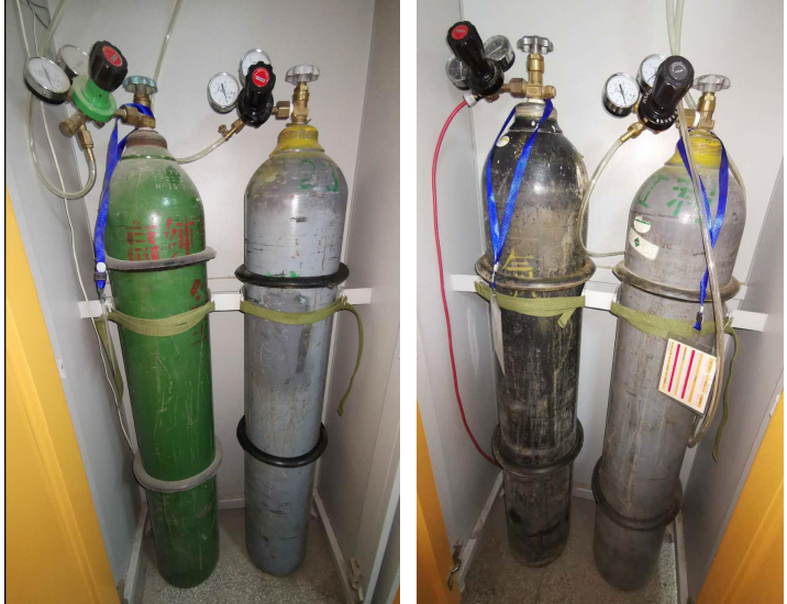
图 10. 格致楼 2053 气瓶无防震胶圈隐患已整改。
