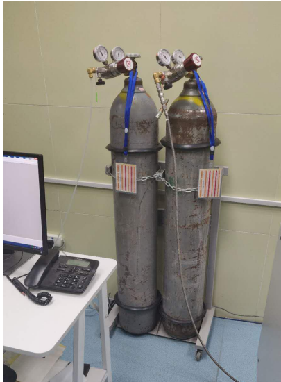
图 9. 格致楼 1037-2 气瓶无防震胶圈隐患已整改。
